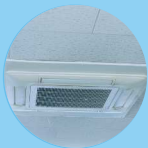
空調の電力量
